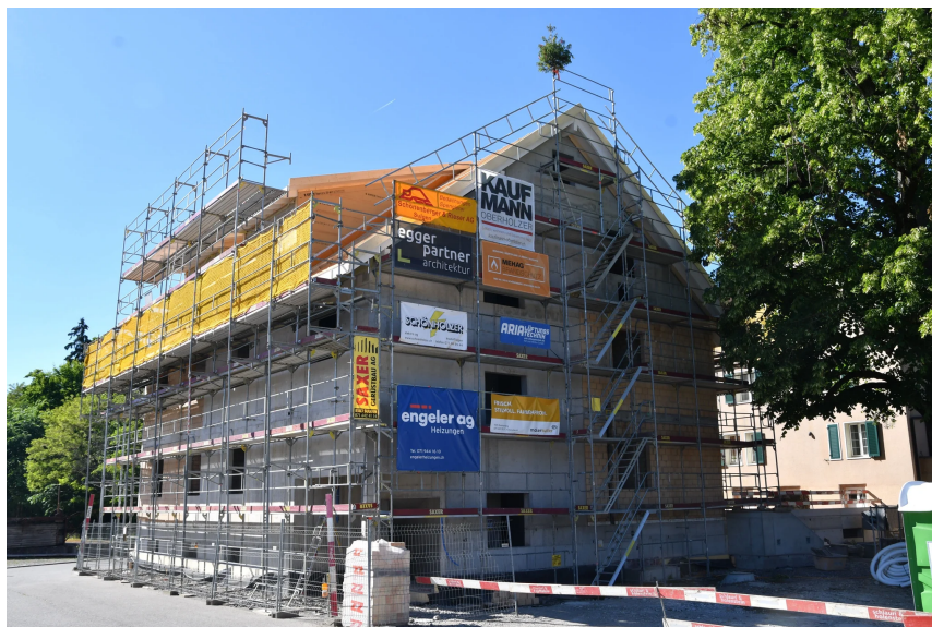
Die «Praxis Q-Med an der Thur» in Schönenberg ist im Rohbau fertiggestellt.
